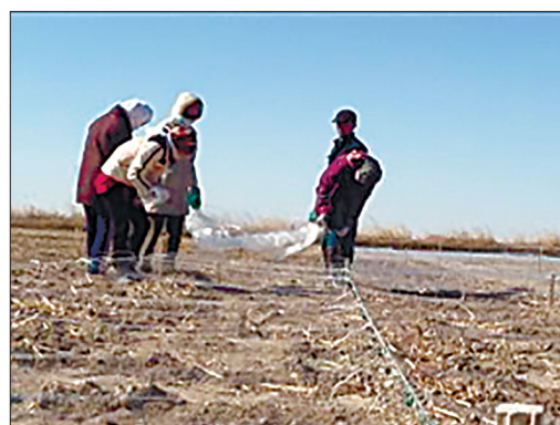
Установка мелкоячеистых сетей для защиты от птиц и грызунов
